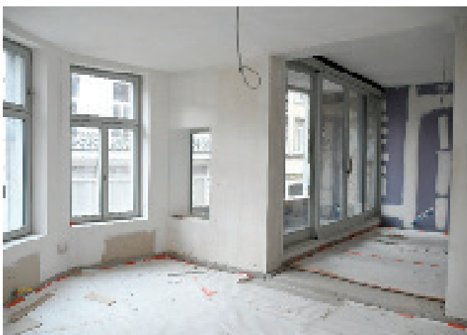
Innenausbau (Fotos: Jean-Pierre Ers, Stadtplanung, Stadt Lüttich)
