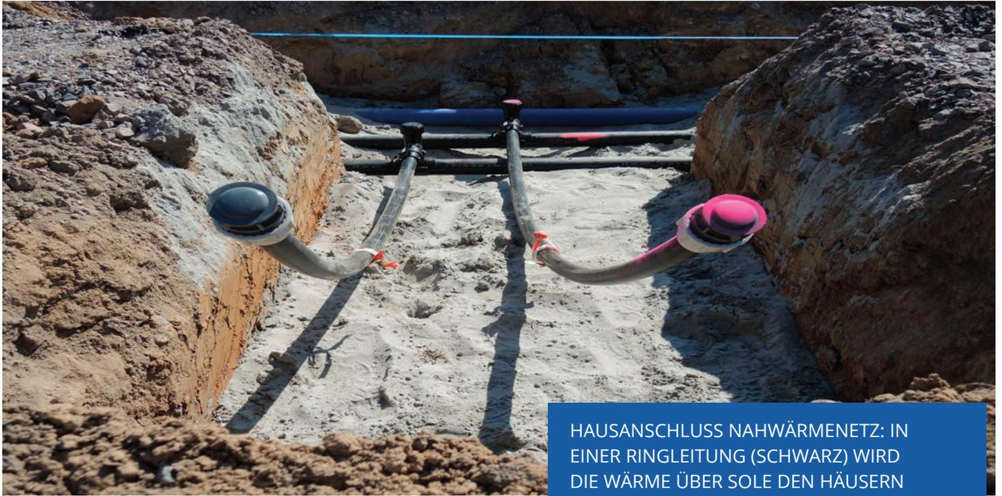
HAUSANSCHLUSS NAHWÄRMENETZ: IN EINER RINGLEITUNG (SCHWARZ) WIRD DIE WÄRME ÜBER SOLE DEN HÄUSERN ZUGLEITET. (© ENERGIEAGENTUR RHEINLAND-PFALZ)
