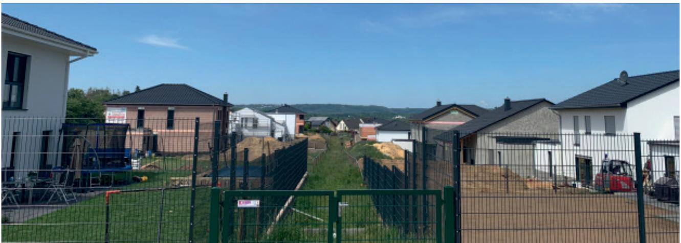
Ansicht des Neubaugebiets Enseldorf Süd II. In der Mitte die Leitungstrasse des Nahwärmenetzes, die auch zur Regenwasserversickerung genutzt wird (Foto: GWBS)
