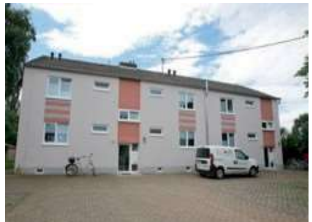
Husarenweg 12 – das vor dem Neubau abgerissene Bestandsgebäude (Foto: GBS)
