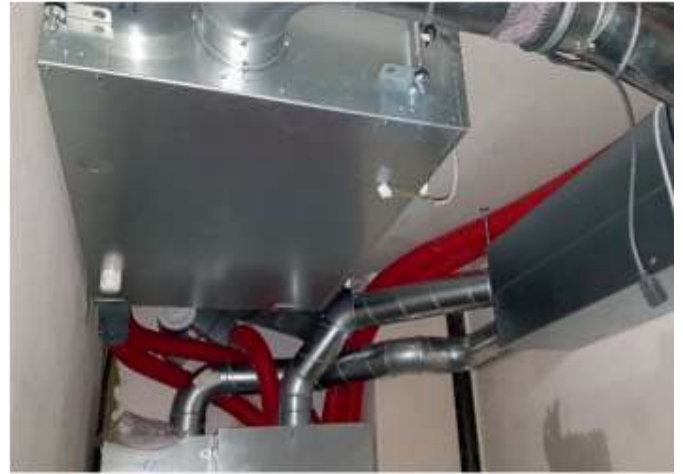
Jede Wohnung hat eine eigene Lüftungsanlage (Foto: ARGE SOLAR)
