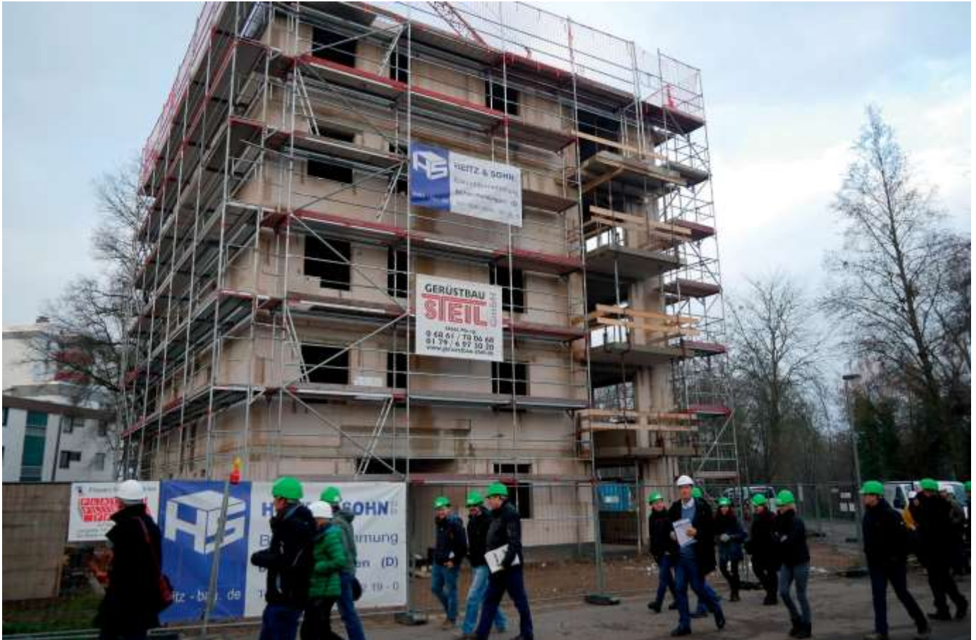
Neubau Husarenweg 12a – Baustellenbegehung am 12. Dezember 2018 (Foto: ARGE SOLAR)
