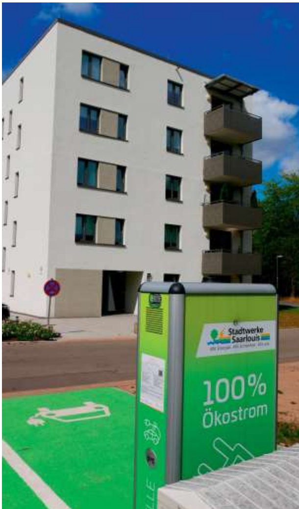
Neubau Husarenweg 12a nach der Fertigstellung. Im Vordergrund die neue Ladestation für Elektroautos der Stadtwerke Saarouis (Foto: ARGE SOLAR)
