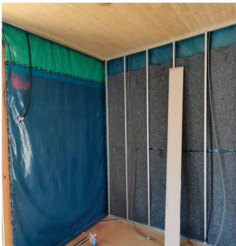
Wasserdichte Membran und Innenisolierung aus recycelter Baumwolle. (Foto: Moselis)
