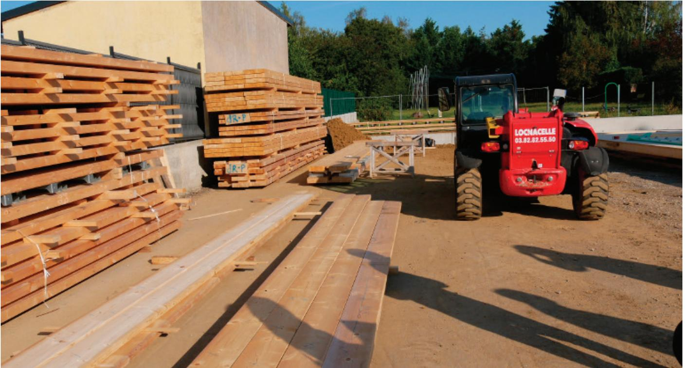
Die Baustelle im September 2020. Die Holzbauteile werden vor Ort zusammengesetzt. Die Zimmermannswerkstatt befindet sich auf der Baustelle. (Foto: ARGE SOLAR)
