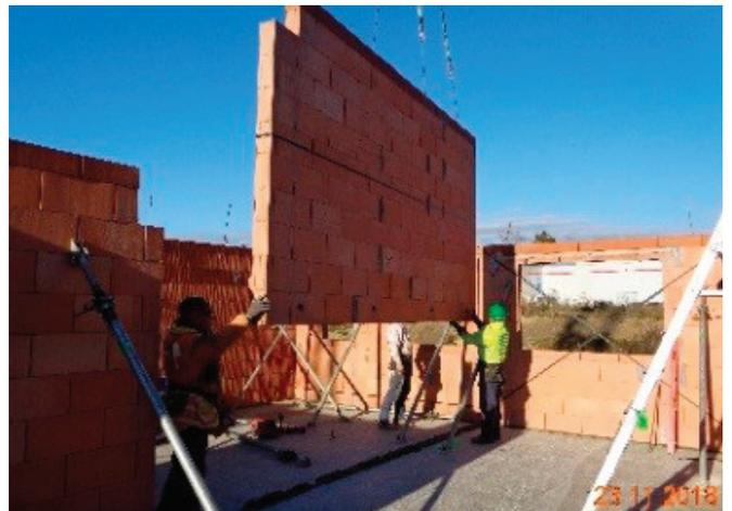
Pour une question de rapidité l'entrepreneur a utilisé des murs préfabriqués en terre cuite qui arrivent sur chantier avec les linteaux non porteurs, par contre les linteaux porteurs sont préfabriqués en béton armé et posés sur chantier. (Photos: La Maison des Hommes)
