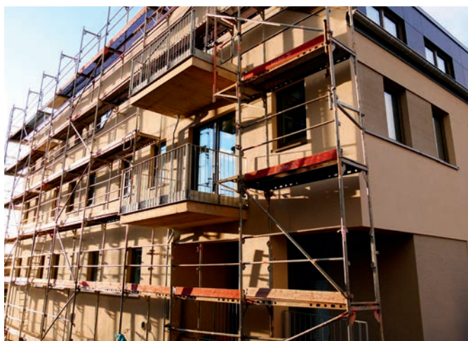
Vue de la zone d'entrée peu avant l'achèvement (Photo : ARGE SOLAR)
