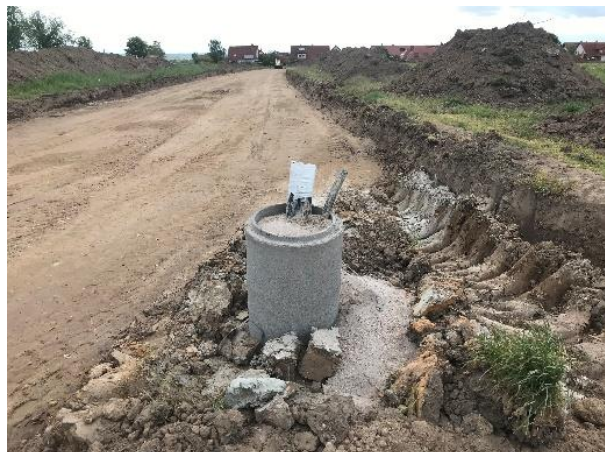
Fertiggestellte Pilotbohrung – Diese erfolgt früh im Bauablauf (Foto: Pfalzwerke)
