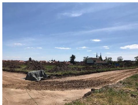
Der Geothermal-Response-Test läuft über eine Dauer von bis 72 Stunden – hier ist die Anlage unter dem Wetterschutz zu sehen (Foto: Pfalzwerke)
