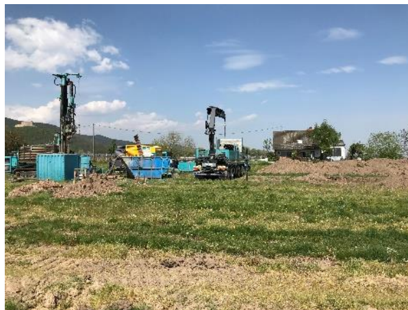
Herstellung der Pilotsonde (Foto: Pfalzwerke)
