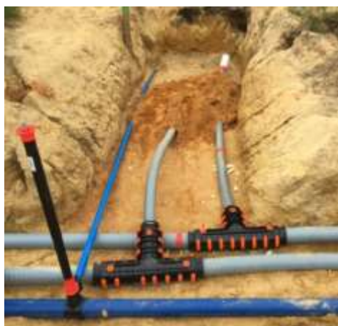
Untere Verlegeebene mit Trinkwasserleitung (blau) und Vor-/Rücklaufleitungen Nahwärme, Fabr. Rehau © GWBS
