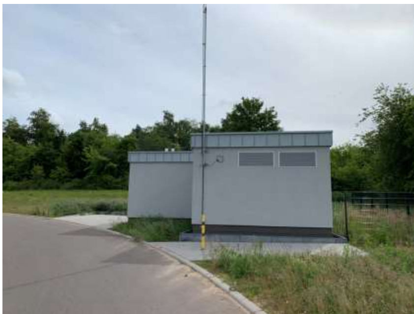
Vorderansicht der Nahwärmestation © GWBS
