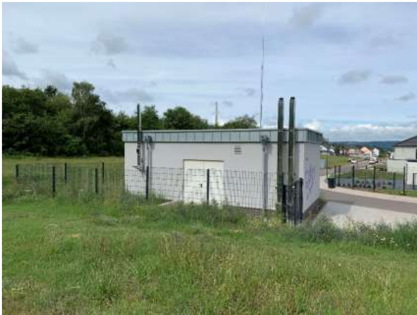
Rückansicht der Nahwärmestation © GWBS
